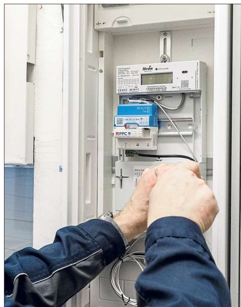
Voraussetzung für die Nutzung von dynamischen Stromtarifen ist ein digitaler Stromzähler mit einem Smart-Meter-Gateway zur Datenübertragung. Ab Januar müssen alle Energieanbieter solche Tarife anbieten. Foto: dpa
